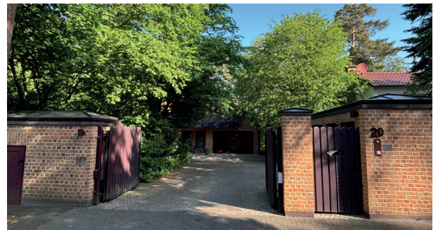
Eingangsbereich mit Parkfläche
